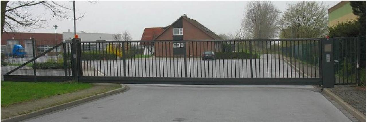
freitragendes Teleskopschiebetor bei reduziertem Schiebefreiraum
